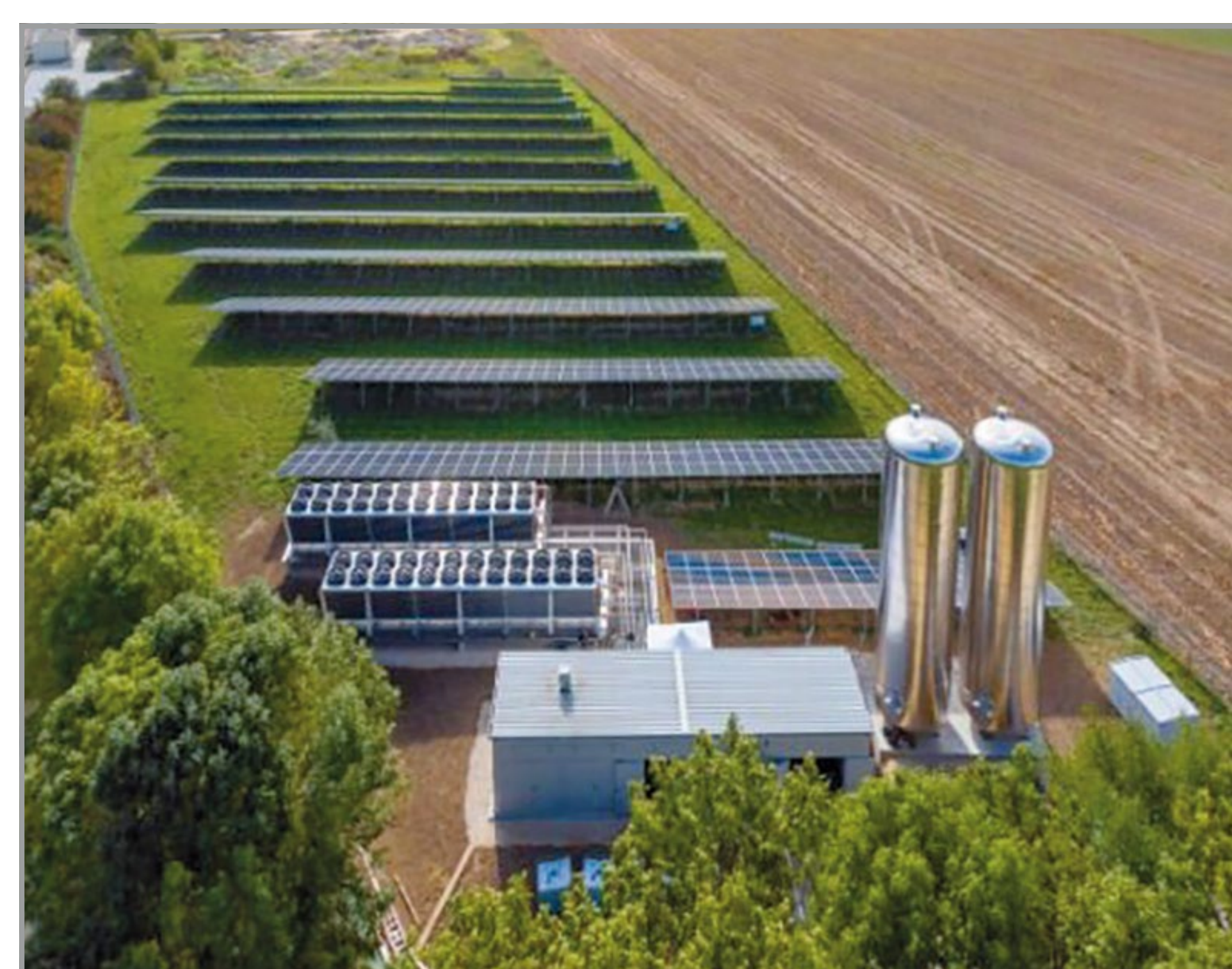
Überblick auf die PV-Anlagen samt Heizzentrale
